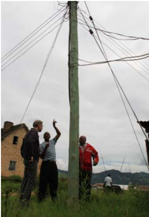
Bild till vänster: Sverker Molander, Chalmers tekniska högskola, har under 2012–2015 lett ett projekt att öka tillgången på el i Tanzanias landsbygd med förnybar energiteknik.
