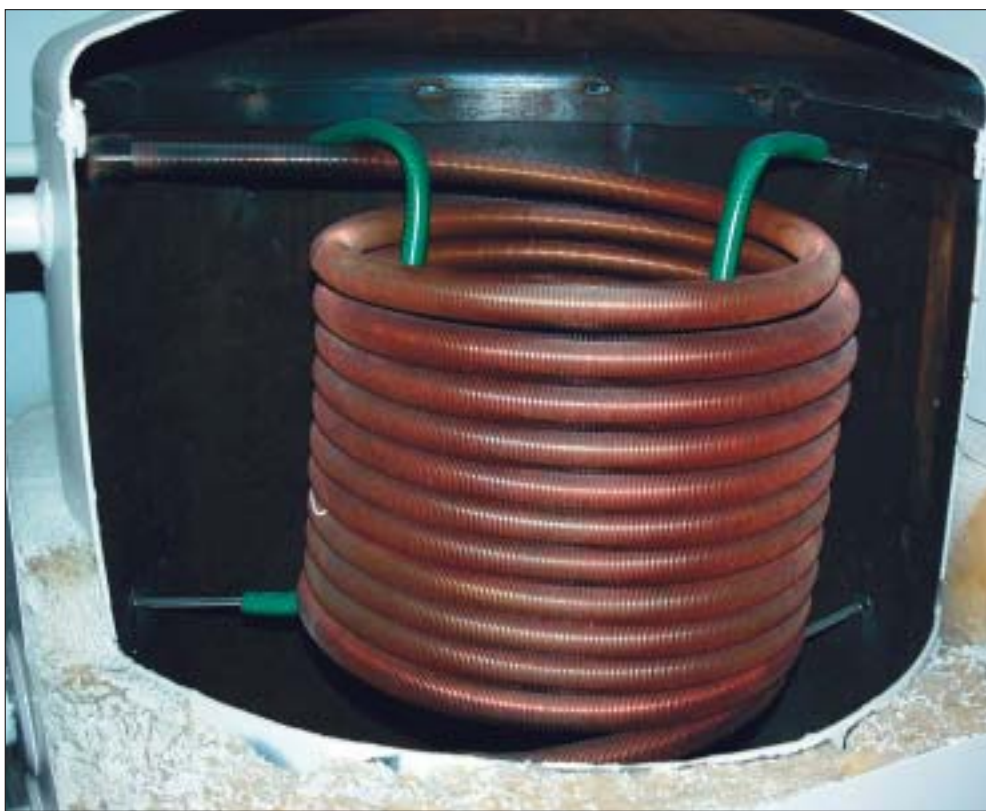
Figur 9. Exempel på ett spirallindat kamflänsrör i en ackumulatortank. Det här kamflänsröret är den övre värmeväxlaren för tappvarmvattenberedning. Den värmeväxlare som används för solfångarkretsen ser likadan ut men sitter i nedre delen av ackumulatortanken. Den här typen av värmeväxlare kallas också för värmebatteri.
